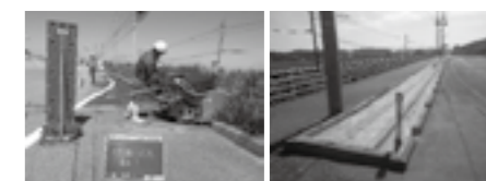
5 mごとに緑石切断 施工完了
