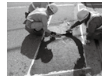
施工状況▶P.85
